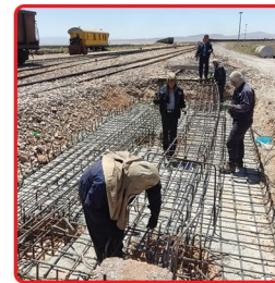
به همت کادر فنی و پیمانکاران داخلی شرکت انجام شد: اصلاح سازه ریلی فولاد خراسان با هدف کاهش استهلاك خطوط و بهبود فرایند توزین
